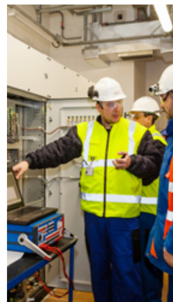
Nastavovanie elektrických ochrán elektrickej rozvodne a transformátora na stavbe 3. a 4. bloku Mochoviec.
