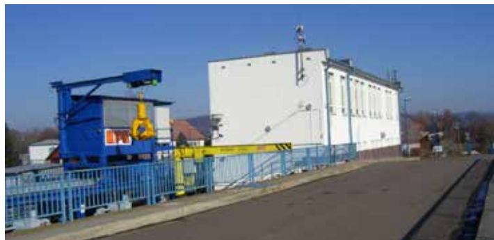
Pohľad na budovu MVE, vľavo otočné rameno na manipuláciu s predmetmi do 2 tis. kg do strojovne, ktorá je pod hladinou vody.
