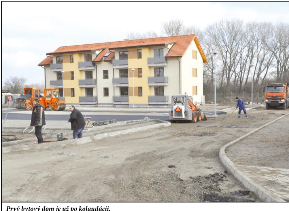
Prvý bytový dom je už po kolaudácii.
